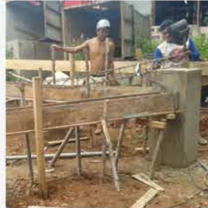
PEMBANGUNAN STEAM PIPE SUPPORT
