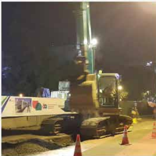
PERKERASAN JALAN - PERBAIKAN SUB BASE
