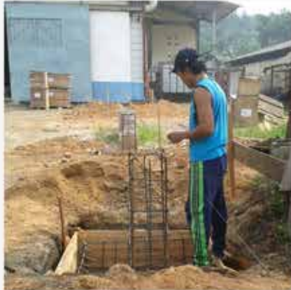
PEMBANGUNAN STEAM PIPE SUPPORT
