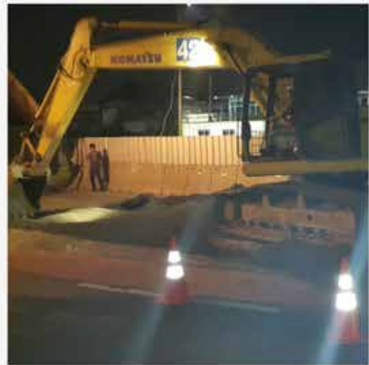
PERKERASAN JALAN - PERBAIKAN SUB BASE
