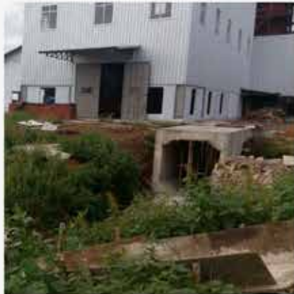
PEMBANGUNAN BOX CULVERT
