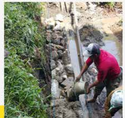
PEKERJAAN DINDING PENAHAN TANAH
