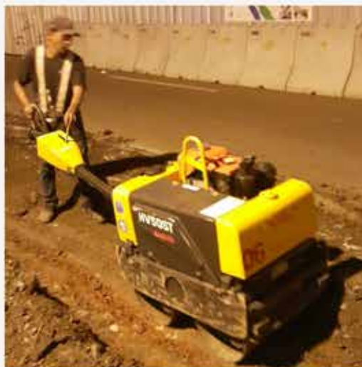
PERKERASAN JALAN - PEMADATAN BASE
